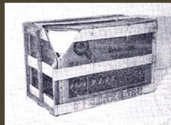
1967年、当時の大型製品の包装はこのような具合。段ボール箱を木枠で包むという手の込んだ仕様に驚愕。
