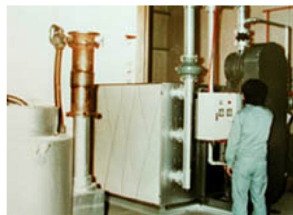
1980年代に採用された燃焼用酸素富化膜ユニットのメンテナンスに当たる富化膜チームスタッフ。現在のブレードは、この当時からノウハウの蓄積によるものといえるだろう。
