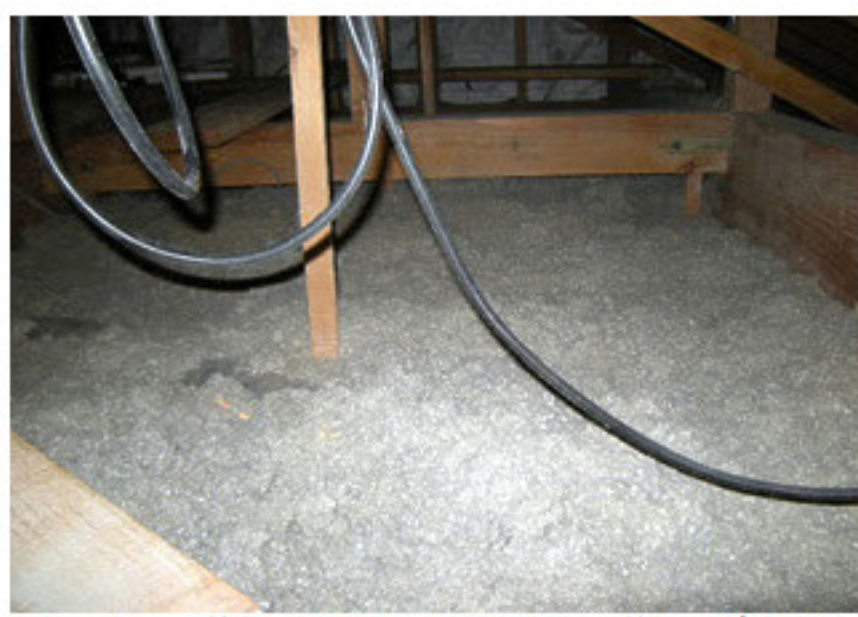
押し入れの天井から屋根裏も見学可能。天井には断熱材が厚く敷かれていた。
