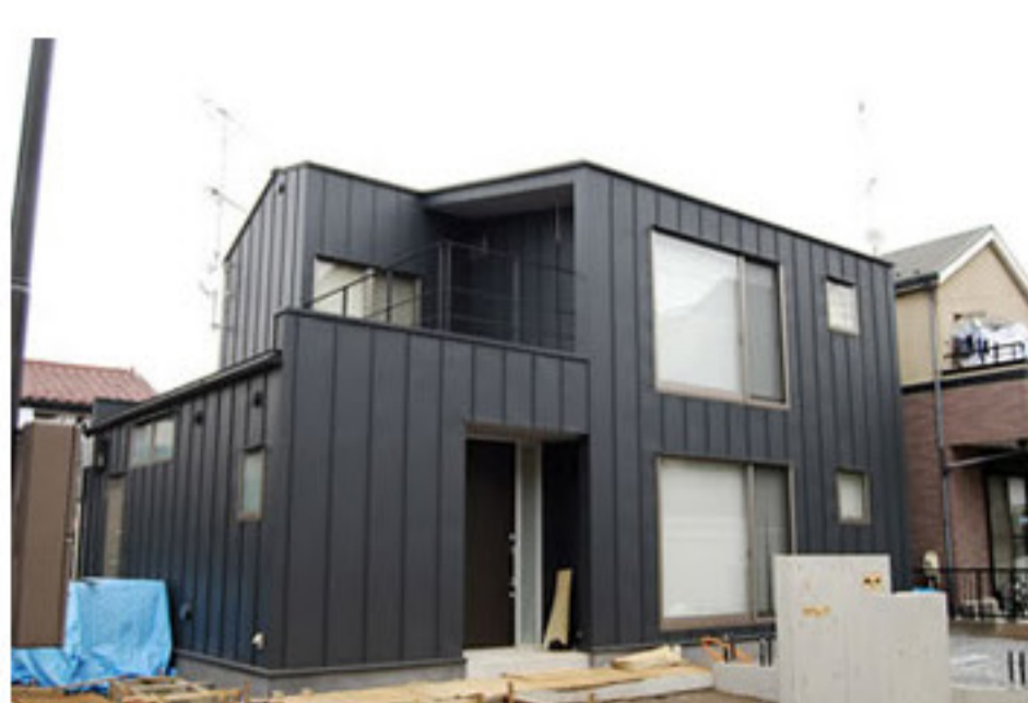
Oさん邸。植や植栽、デッキはこれから設置される予定。デッキや植栽は放射熱を緩和する役割を果たす
