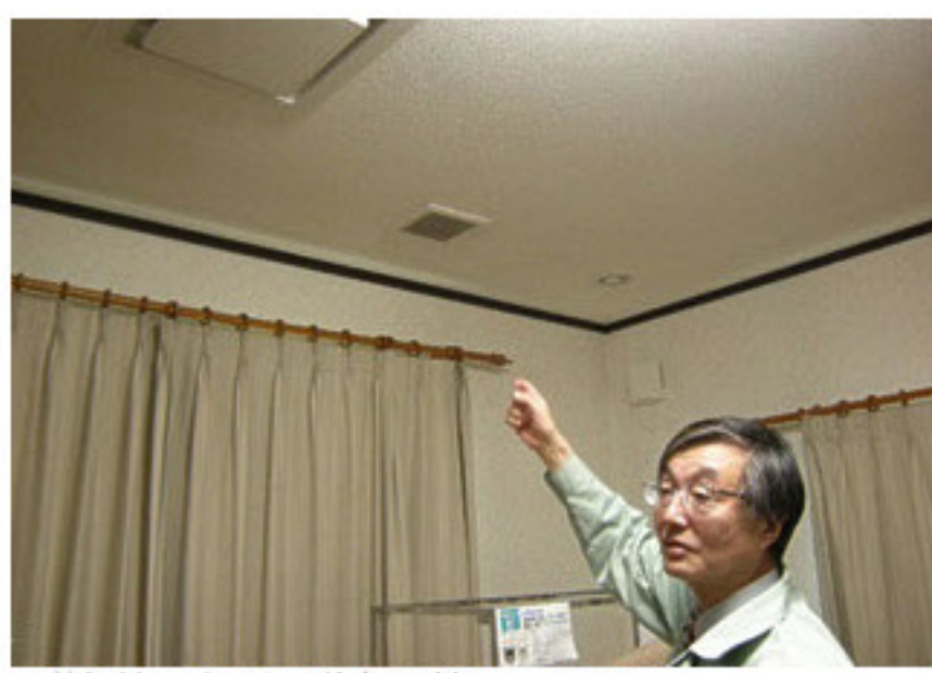
天井にはいくつもの換気口がついている。
