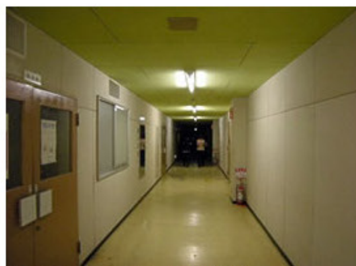
通路を歩くと自動的に蛍光灯が点灯する。
