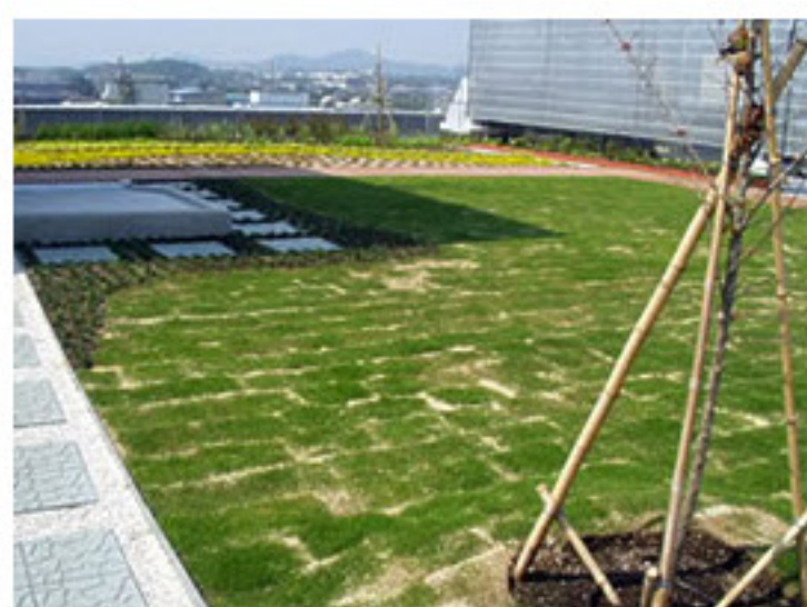
緑化された技術棟の屋上。
