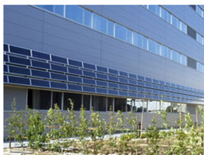
技術棟の南壁面に設置されたソーラーパネル。
