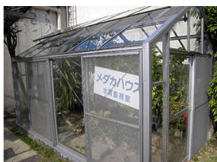
浄水設備に隣接しているメダカハウス。
