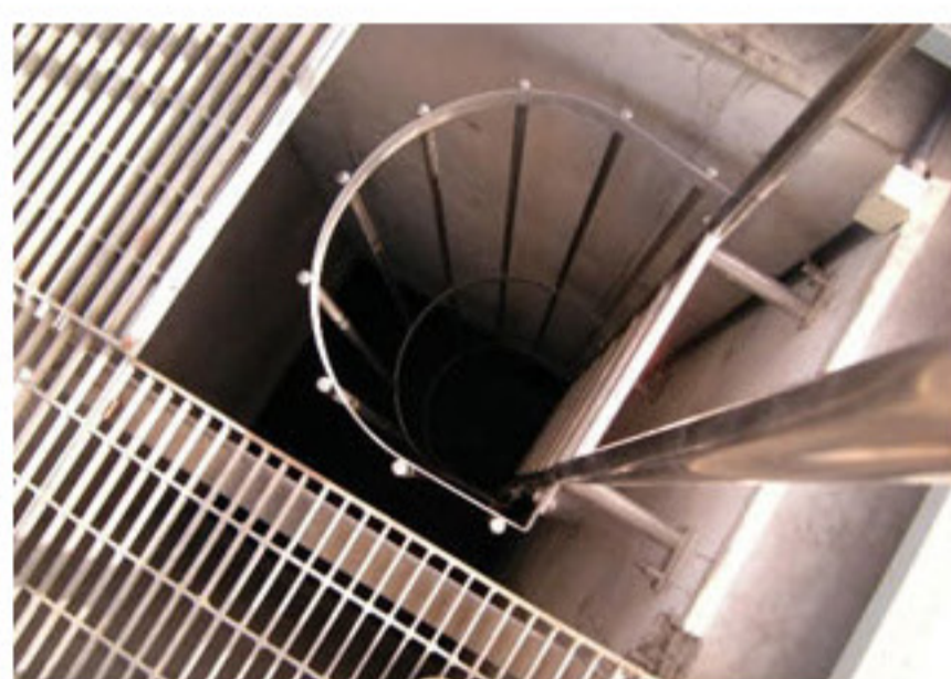
地下トンネルに通じるはしご。地面は見えない。
