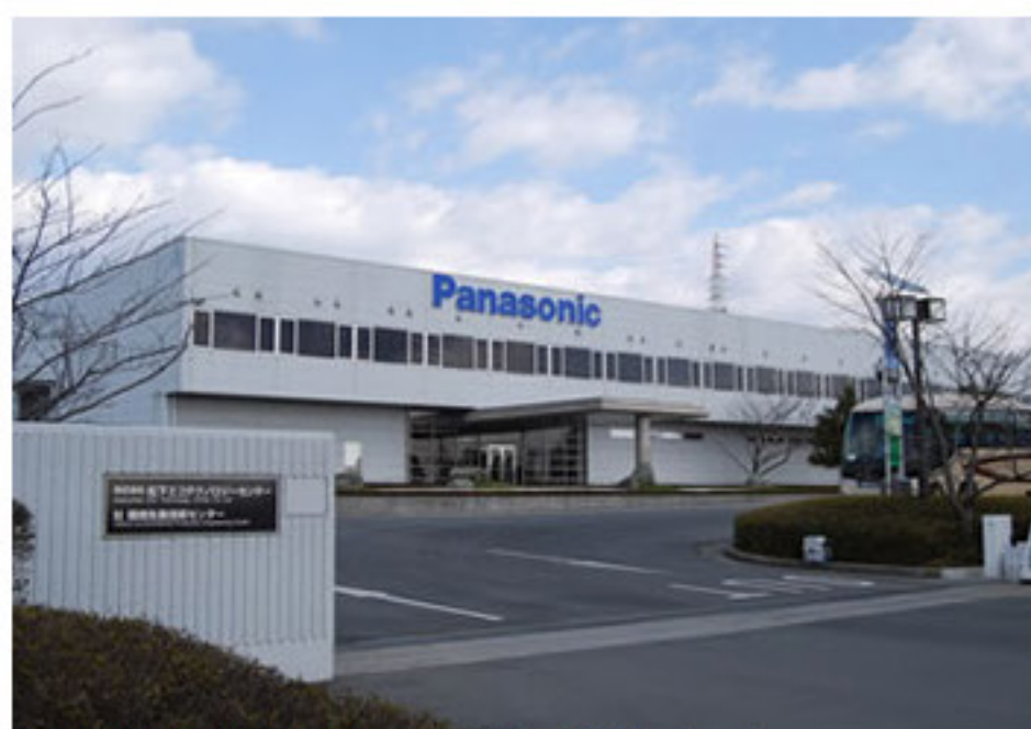
兵庫県加東市にある松下エコテクノロジーセンター。
