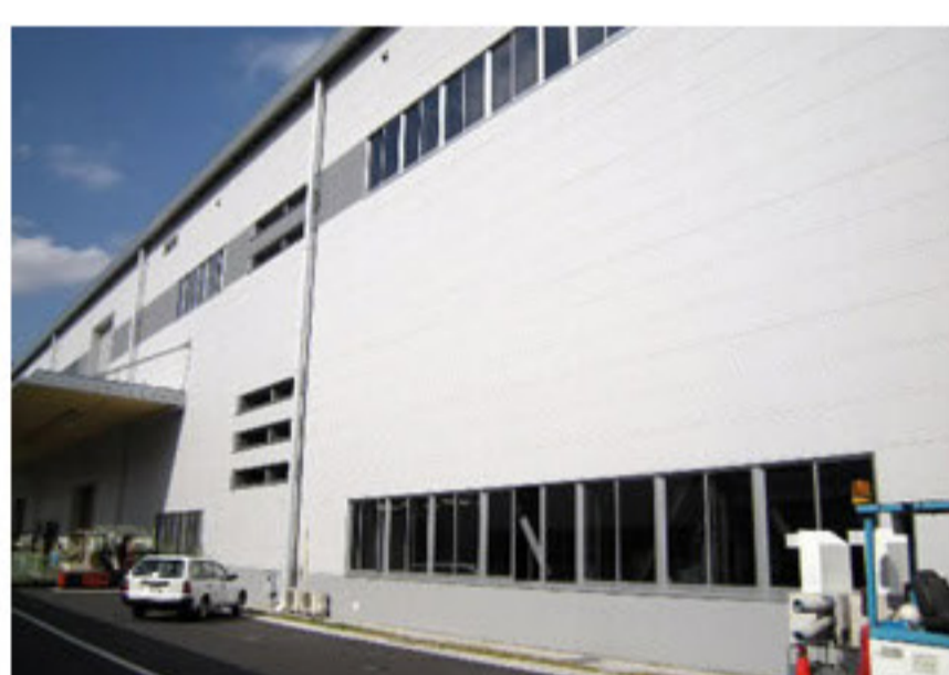
新工場の壁面。駐車中の自動車の上の穴が換気口。
