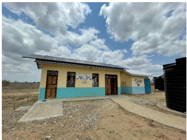
ソーラーパネルを設置し、建屋が完成した様子
