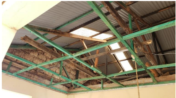
改築中の屋根(当時)
