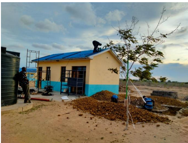
産科室の屋根にソーラーパネルを設置し、手前に PSS のための建屋を建設している様子
