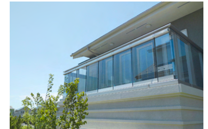
Fujisawa SST内モデルハウスでの実証実験まち・くらしに調する「発電するガラス」と位置付けています
