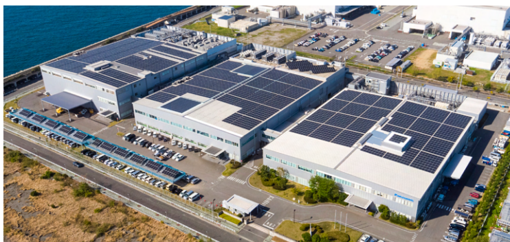
二色の浜・乾電池工場の太陽光発電システム
