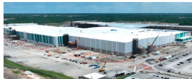
EVバッテリー増産に向けて建設中のカンザス工場 (2024年4月時点)
