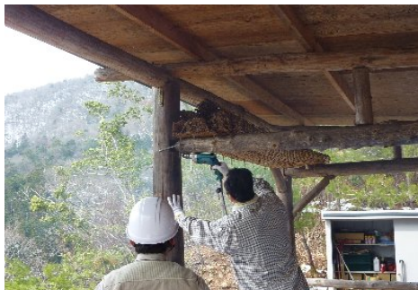
作業小屋を修復する
